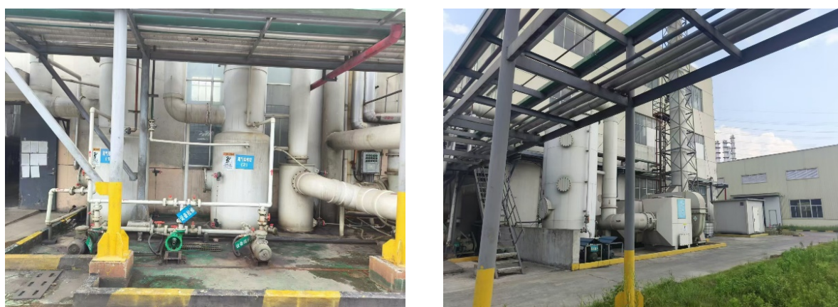
图 3.5-1 全厂废气收集处置情况
